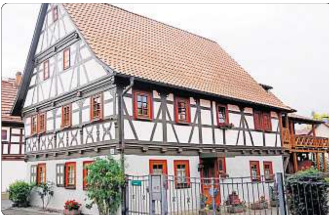
Für das Gehöft in der Dorfstraße 11 in Sülzfeld erhielt Eigentümerin Ulrike Fehring im vergangenen Jahr den Denkmalpreis des Landkreises Schmalkalden-Meiningen. Foto: LRA
